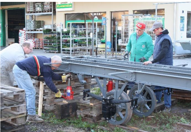
Einbau einer Achse mittels Hydraulik-Hebeböcken.
