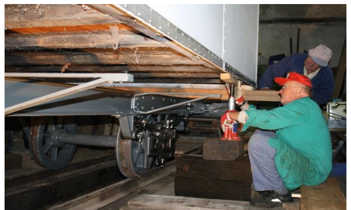
Absenken des Wagenkastens auf das Fahrgestell rückwärts.
