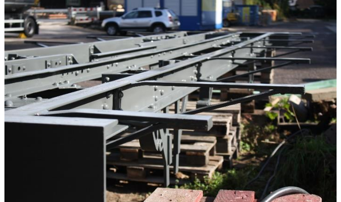
Das Fahrgestell (Längsträger neu) genietet, zweimal grundiert und verkehrsgrau lackiert.
