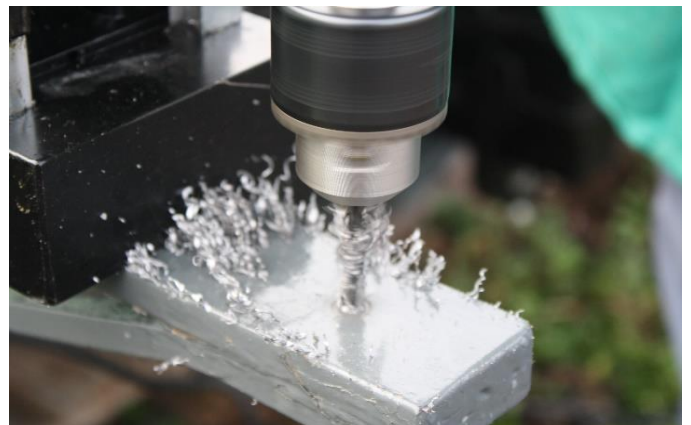
Bohrungen der Holzkastebefestigungen mittels Magnetbohrmaschine (10 x M12).
