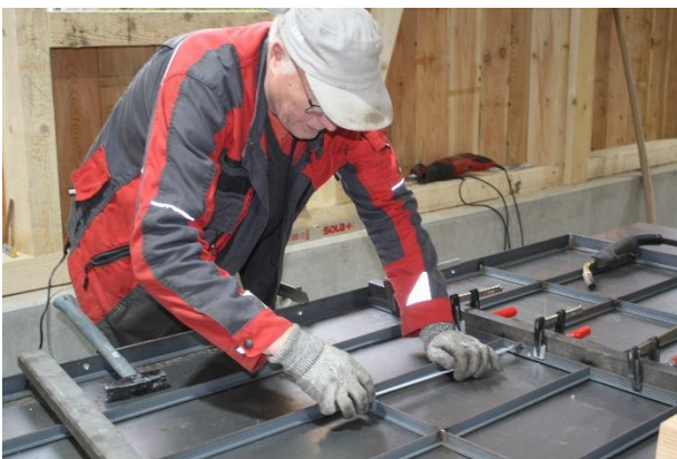
Anfertigen der Fensterrahmen
