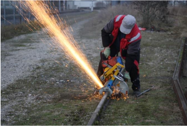
Zerteilen der Schienen auf 10 m Stücke
