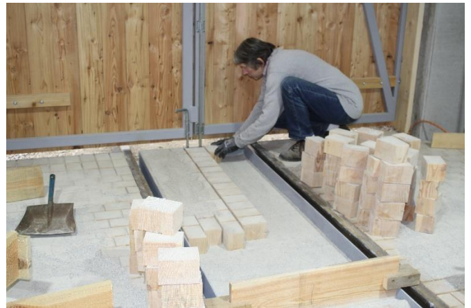
Verlegearbeiten zwischen den Schienen
