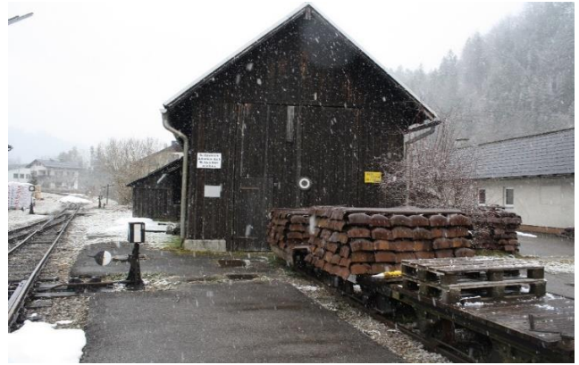
Die Remise wird umgebaut und soll zweigleisig vier Fahrzeuge beherbergen und als Werkstätte dienen.
