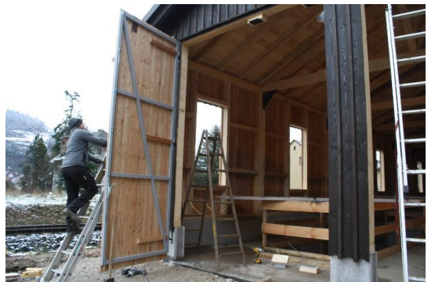
Die Tore werden montiert
