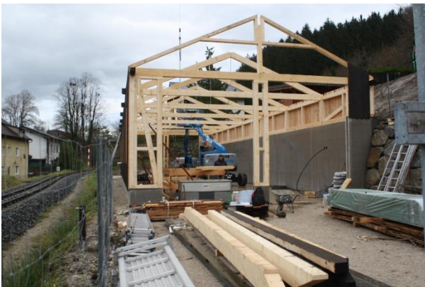
Holzkonstruktion von vorne gesehen
