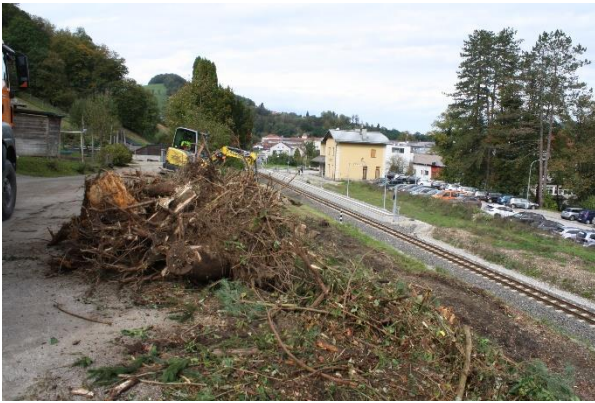
Roden der zukünftigen Baustelle
