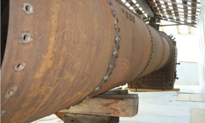
Der Kessel der 598.03 vor dem Sandstrahlen. Der Waggon wurde mit Vliesstoff ausgekleidet.
