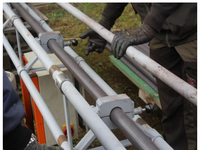
Schnellverschlüsse gegen das Ausknicken des Rohres beim Einziehen und Aufweiten.
