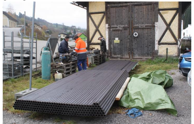
Beim Einziehen der Heizrohre (240 Stück, gleich ein zweiter Rohrsatz).
