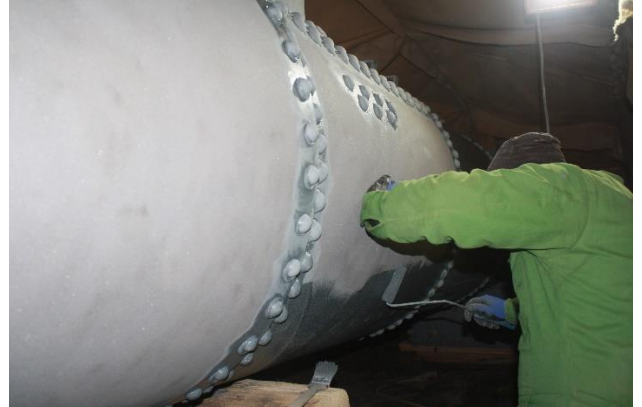
Nach dem Sandstrahlen wird die Farbe aufgetragen.
