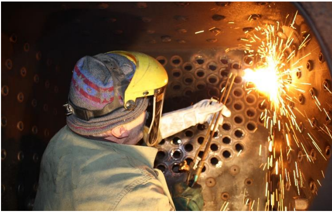
Mittels Autogenschneiden werden die Bördelringe der Heizrohre in der Feuerbox abgebrannt.
