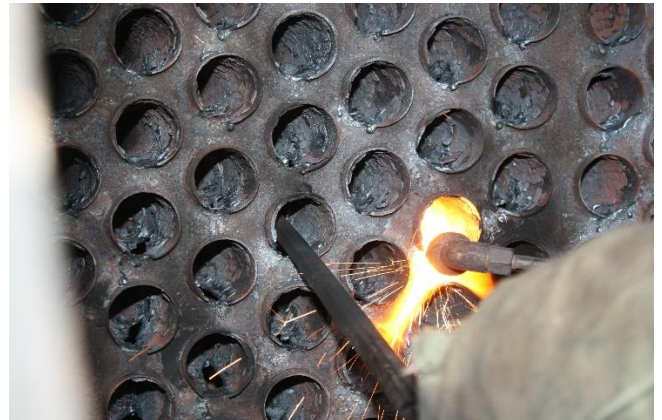
Die Heizrohre rauchkammerseitig werden autogen eingeschnitten.
