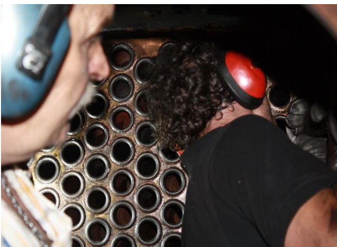
Das Bördeln der Heizrohre mit Druckluft-Formmeißel.
