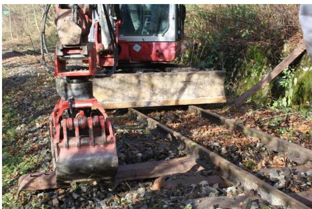
Drei Bilder können den Riesenaufwand des Schwellentausches nur andeuten. Vom Stapel in Lunz werden die Schwellen auf die Strecke gebracht (ca. 140 Stück/100 m). Mit der Baggerschaufel wird eine Holzschwelle seitlich unter den Schienen herausgezogen. In den schotterfreien Raum unter den Schienen wird die Stahlschwelle eingeschoben. Diese wird mit vier Klemmplatten und vier Schrauben mit den Schienen verbunden und mit Schotter verfüllt. Leistung/Tag: 80 - 90 Schwellen tauschen!
